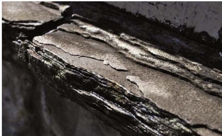
Abb. 13: Abdeckplatten an der Lechbrücke in Lechbruck lösen sich blätterteigartig auf.
