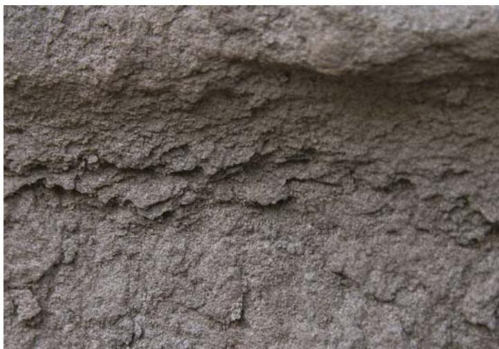
Abb. 8: Schuppige Verwitterung an einem "auf Spalt" eingesetztem Gewände in Kirchberg, Schweiz.
