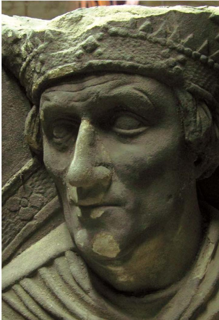
Abb. 16 In einer großflächigen Gipskruste kommt es zu Spannungen und Abplatzungen, Abt-Epitaph Steingaden.
