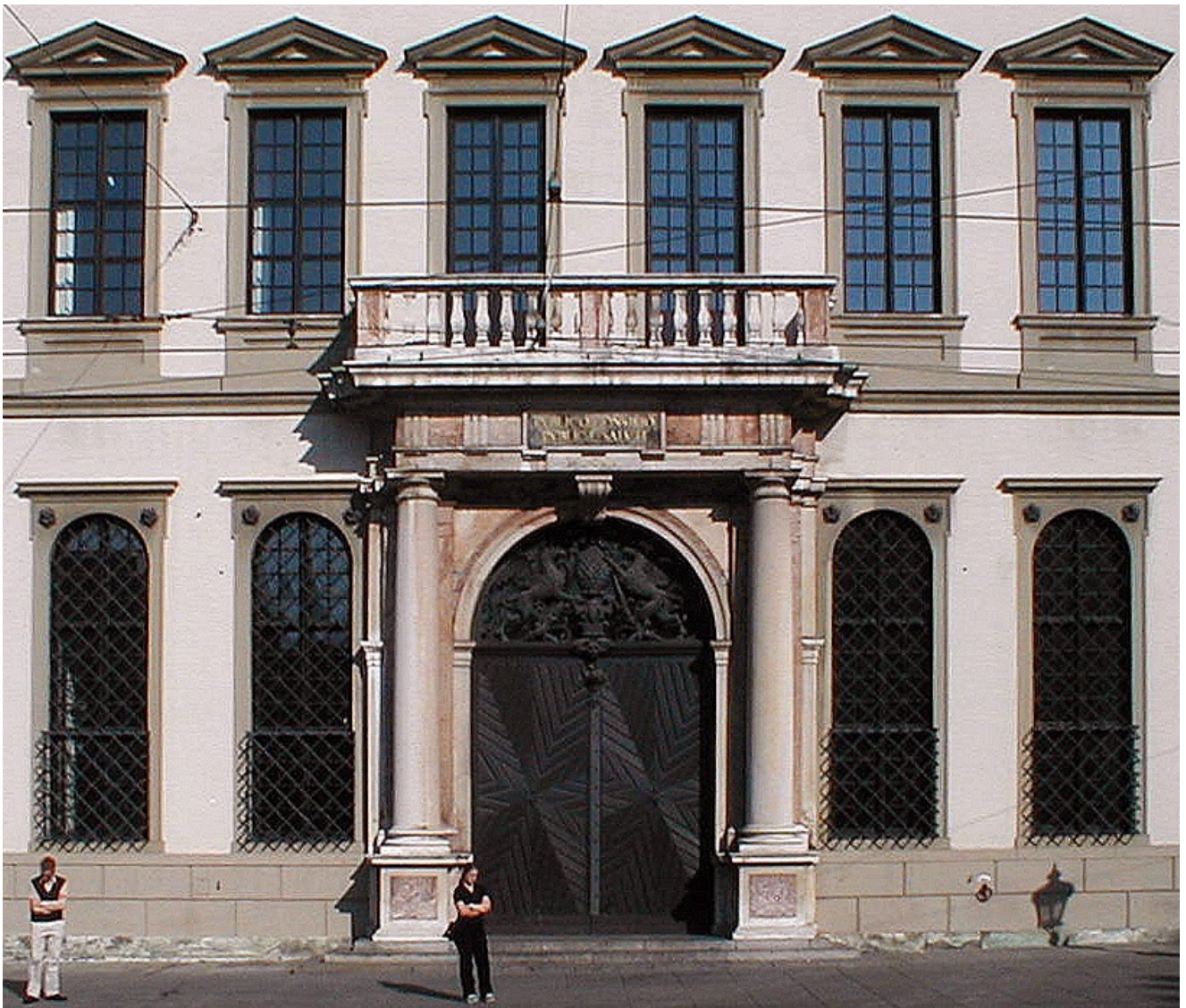
Elias Holl, Portal des Rathauses in Augsburg - Orientierung an der italienischen und römischen Baukunst
